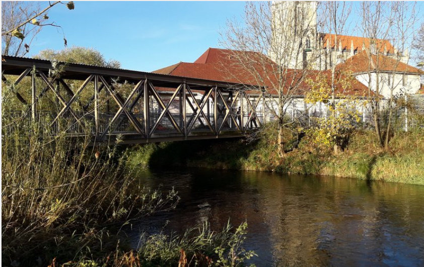
Passerelle de Doubs (CCGP)
