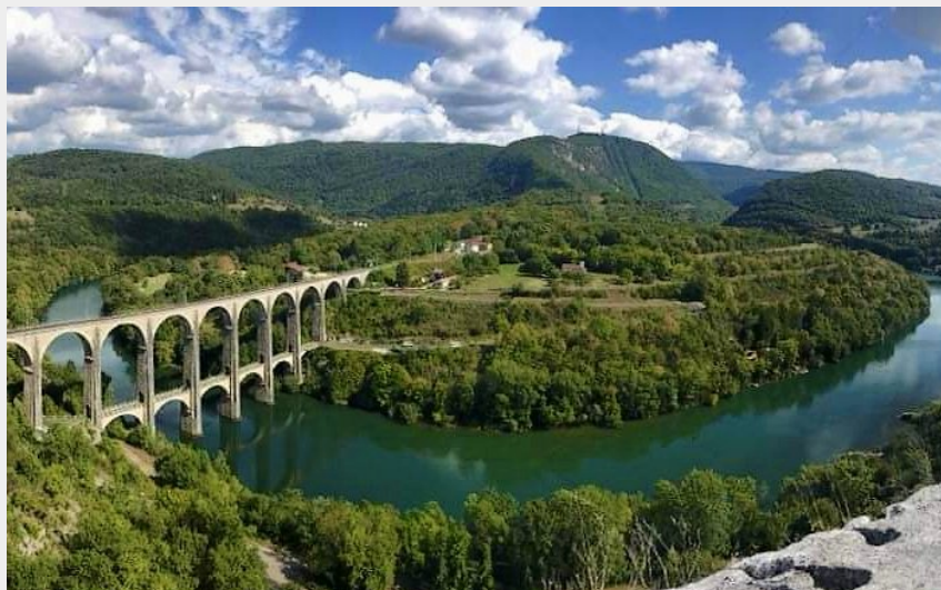
viaduc de Cize
