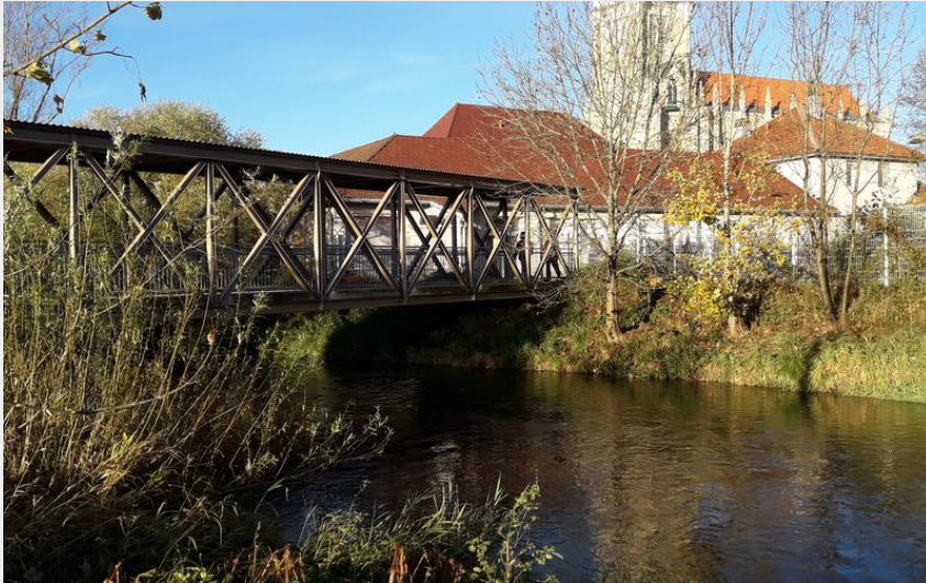
Passerelle de Doubs (CCGP)
