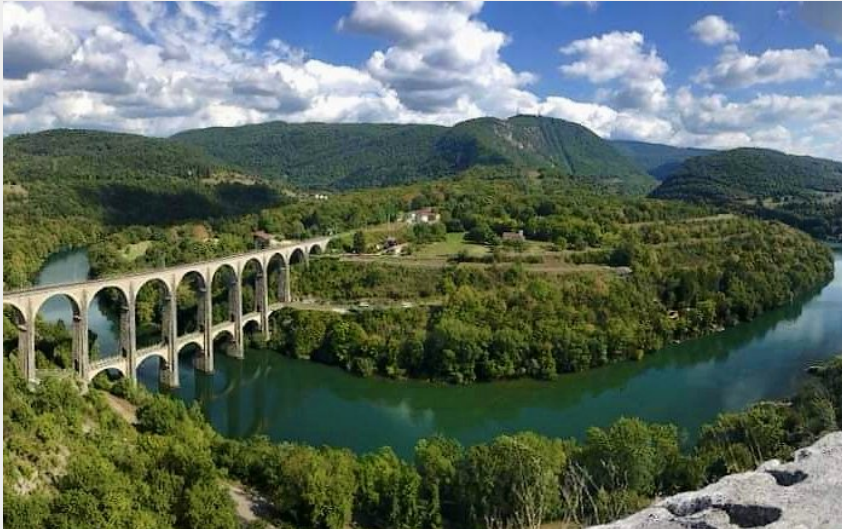
viaduc de Cize
